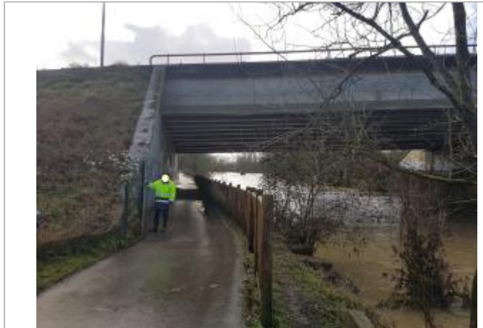
Vue du site - Source : DREAL Grand Est/CEREMA 2018
