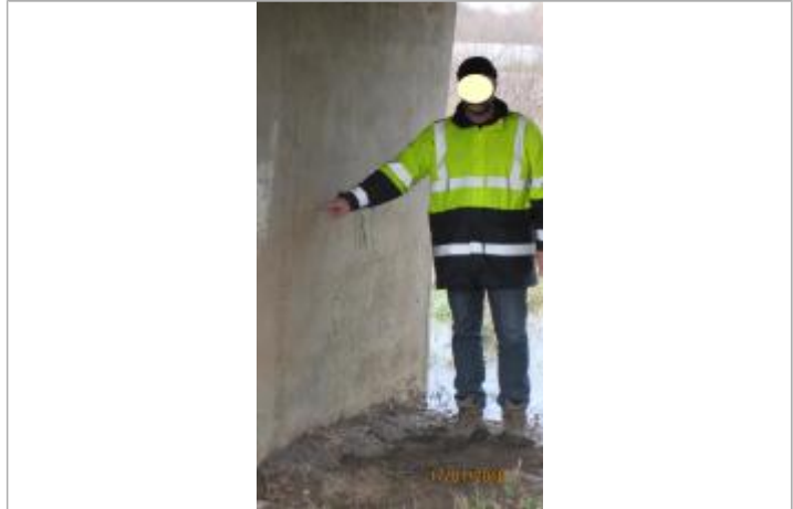
Vue du repère - Source : DREAL Grand Est/CEREMA 2018
