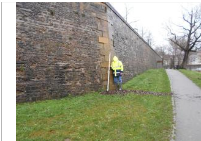
Vue du site - Source : DREAL Grand Est/CEREMA 2018
