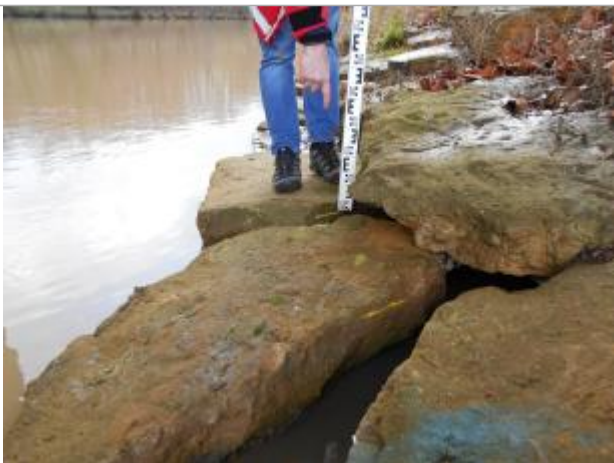
Vue du repère - Source : DREAL Grand Est/CEREMA 2018
