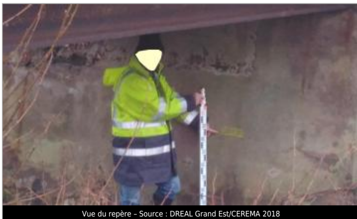
Vue du repère - Source : DREAL Grand Est/CEREMA 2018
