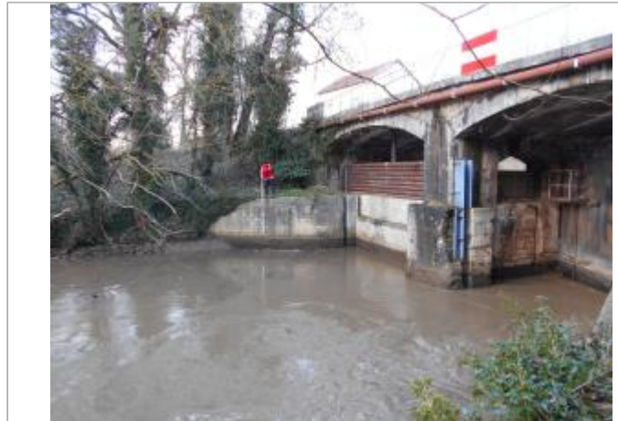
Vue du site - Source : DREAL Grand Est/CEREMA 2018
