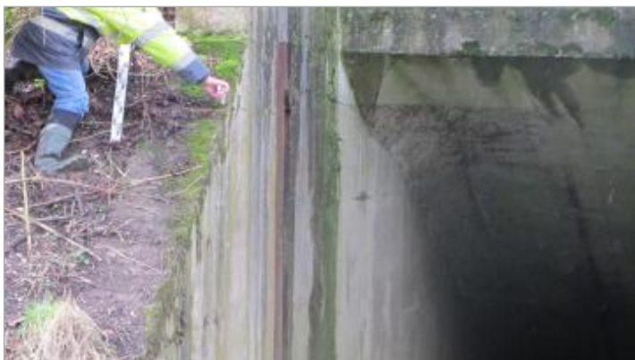
Vue du repère - Source : DREAL Grand Est/CEREMA 2018
