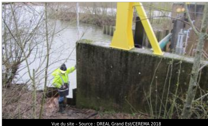
Vue du site - Source : DREAL Grand Est/CEREMA 2018
