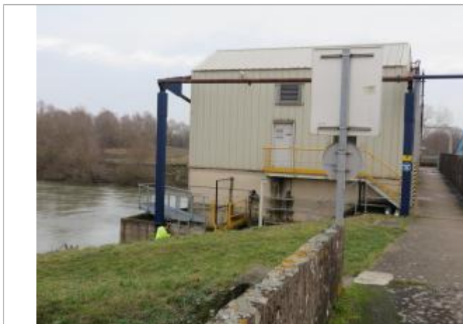
Vue du site - Source : DREAL Grand Est/CEREMA 2018
