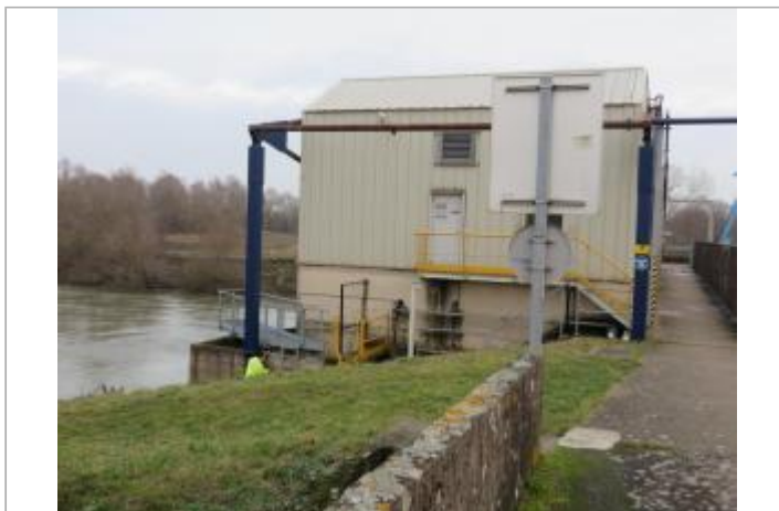
Vue du site - Source : DREAL Grand Est/CEREMA 2018
