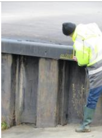
Vue du repère - Source : DREAL Grand Est/CEREMA 2018
