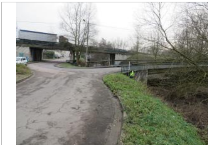
Vue du site - Source : DREAL Grand Est/CEREMA 2018
