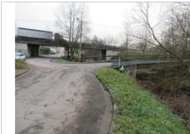
Vue du site - Source : DREAL Grand Est/CEREMA 2018
