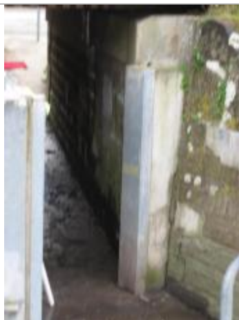
Vue du repère - Source : DREAL Grand Est/CEREMA 2018
