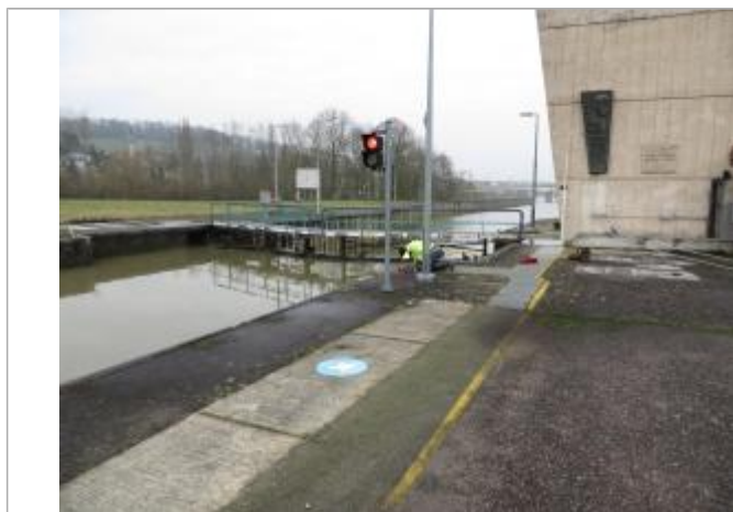
Vue du repère - Source : DREAL Grand Est/CEREMA 2018
