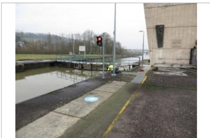
Vue du repère - Source : DREAL Grand Est/CEREMA 2018
