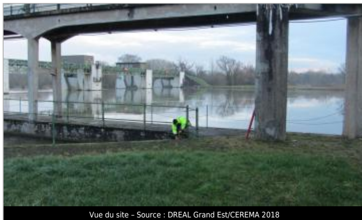
Vue du site - Source : DREAL Grand Est/CEREMA 2018
