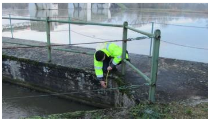
Vue du repère - Source : DREAL Grand Est/CEREMA 2018
