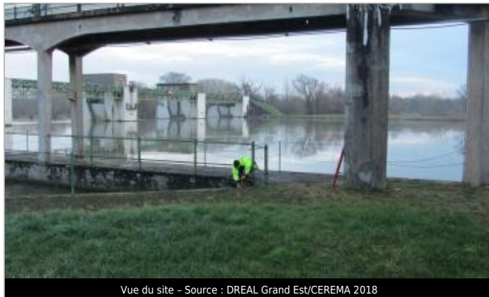
Vue du site - Source : DREAL Grand Est/CEREMA 2018
