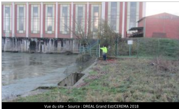
Vue du site - Source : DREAL Grand Est/CEREMA 2018
