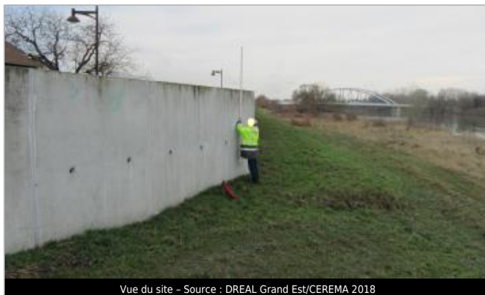
Vue du site - Source : DREAL Grand Est/CEREMA 2018
