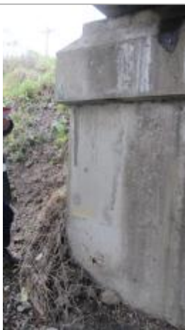
Vue du repère - Source : DREAL Grand Est/CEREMA 2018
