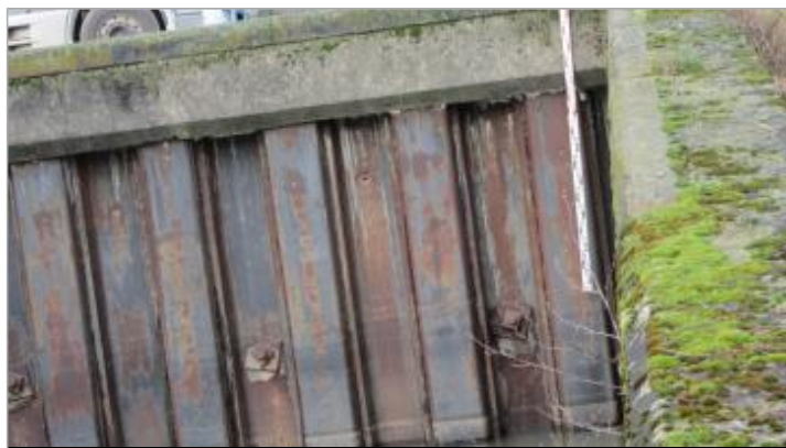
Vue du repère - Source : DREAL Grand Est/CEREMA 2018
