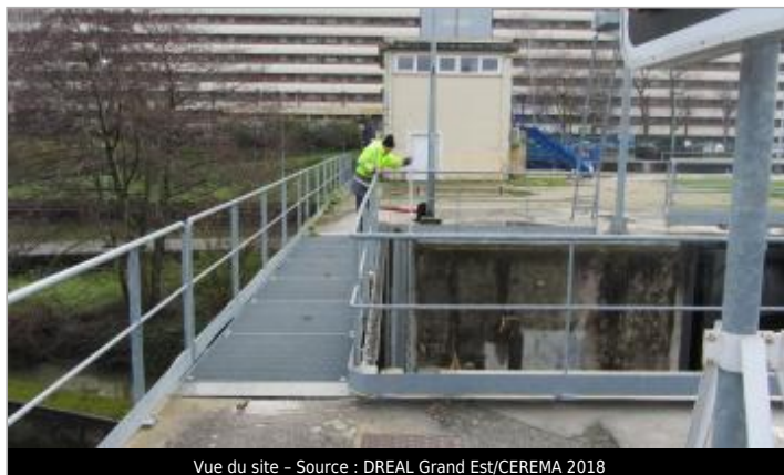
Vue du site - Source : DREAL Grand Est/CEREMA 2018
