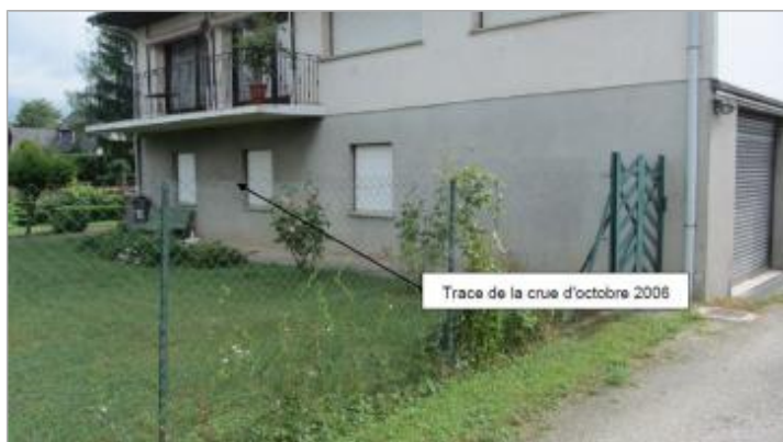
Trace encore visible en 2016 sur le crépis ciment du sous-bassement de la maison
