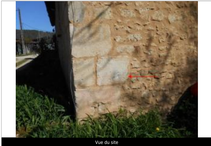
Vue du site
