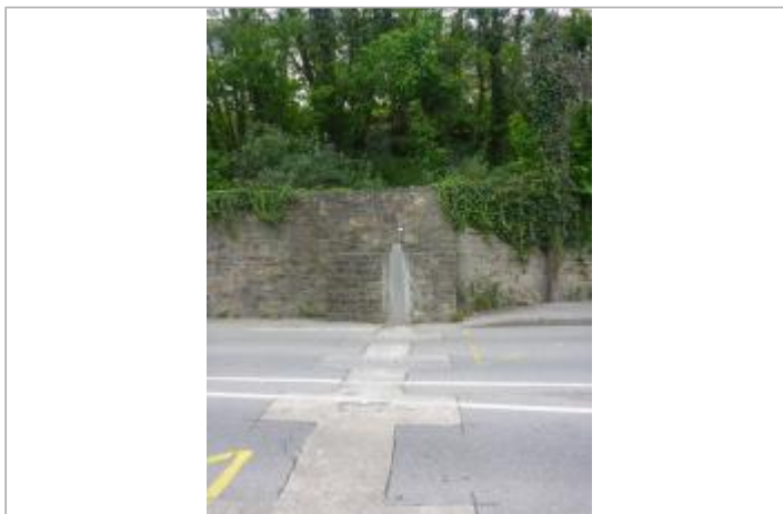
14, rue de l'Hippodrome - Batardeau
