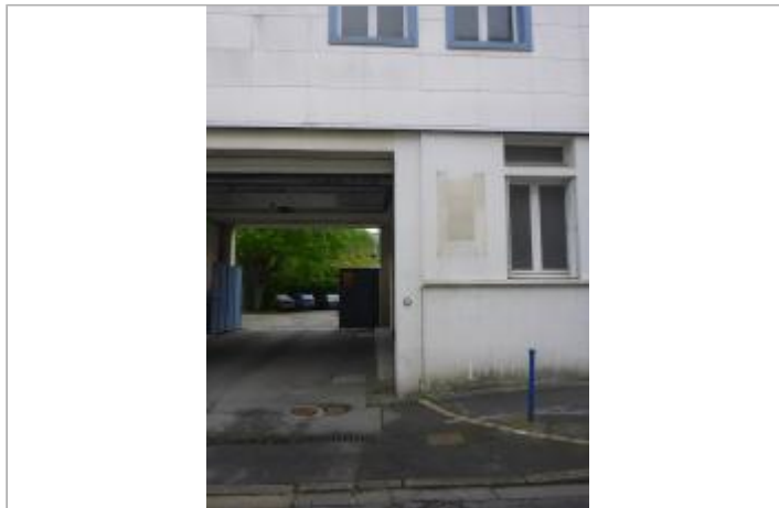
31, rue de la Providence - Accès véhicules ITEP Le Maître
