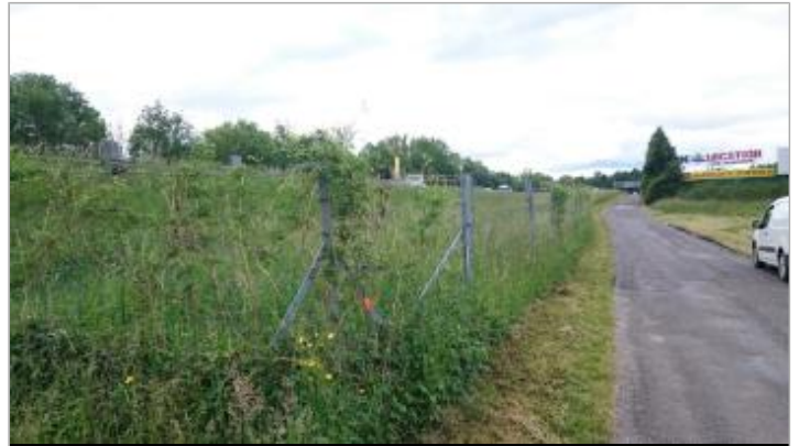
grillage sur voie communale n°9
