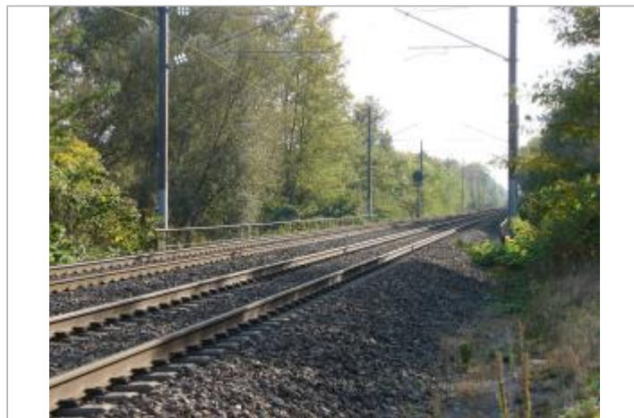
Vue générale du site
