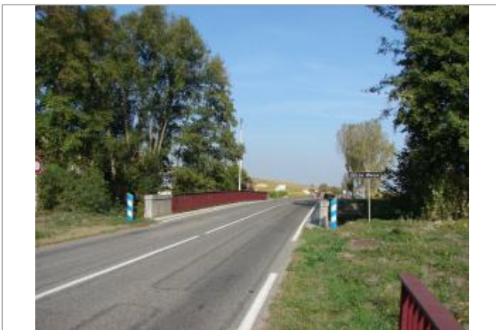
Vue général du site
