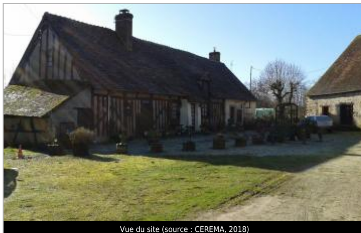
Vue du site (source : CEREMA, 2018)
