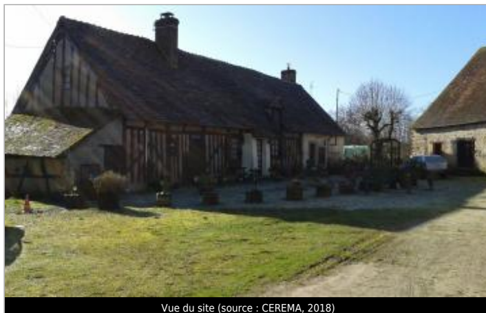
Vue du site (source : CEREMA, 2018)
