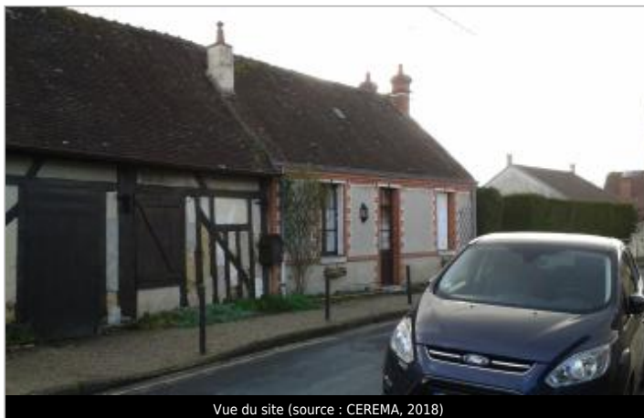
Vue du site (source : CEREMA, 2018)
