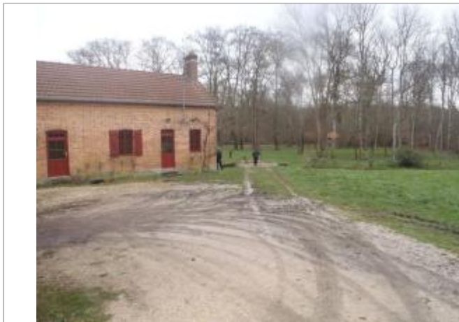
Vue du site (source : CEREMA, 2018)
