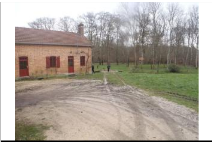
Vue du site (source : CEREMA, 2018)
