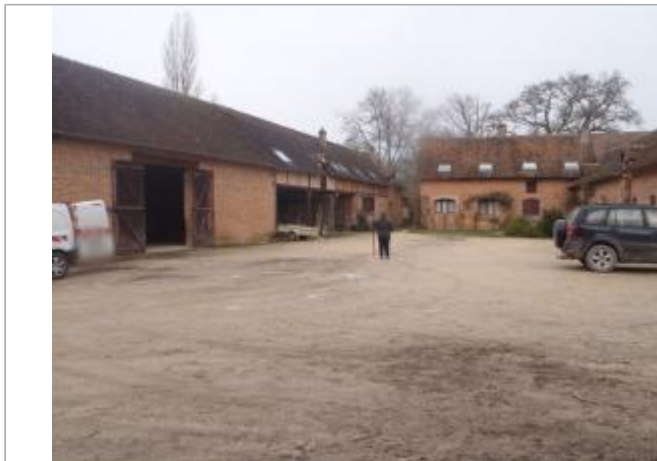
Vue du site (source : CEREMA, 2018)
