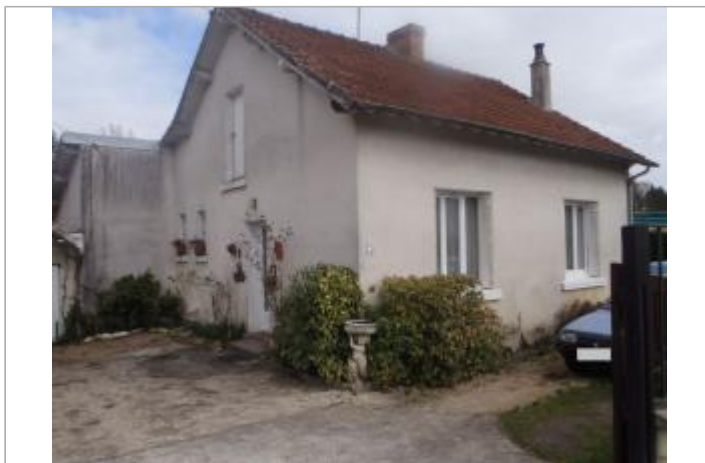
Vue du site (source : CEREMA, 2018)
