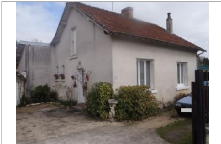
Vue du site (source : CEREMA, 2018)
