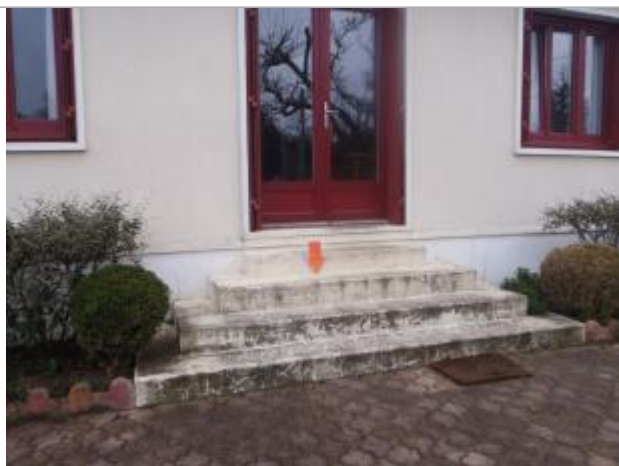
Vue du repère (source : CEREMA, 2018)
