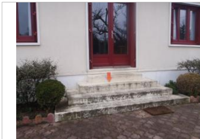
Vue du repère (source : CEREMA, 2018)
