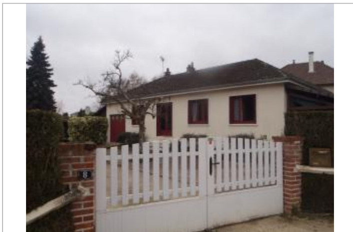
Vue du site (source : CEREMA, 2018)
