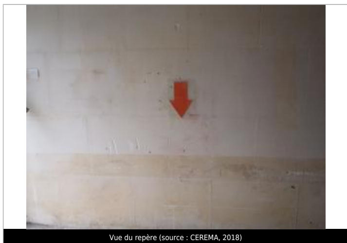
Vue du repère (source : CEREMA, 2018)
