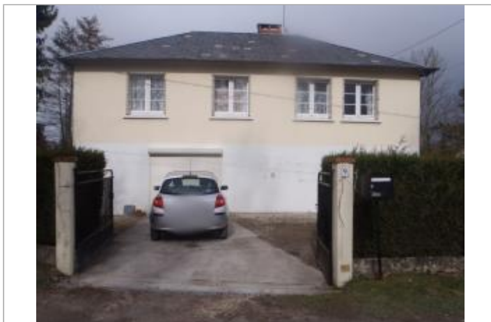
Vue du site (source : CEREMA, 2018)
