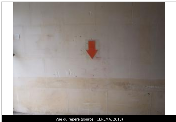
Vue du repère (source : CEREMA, 2018)
