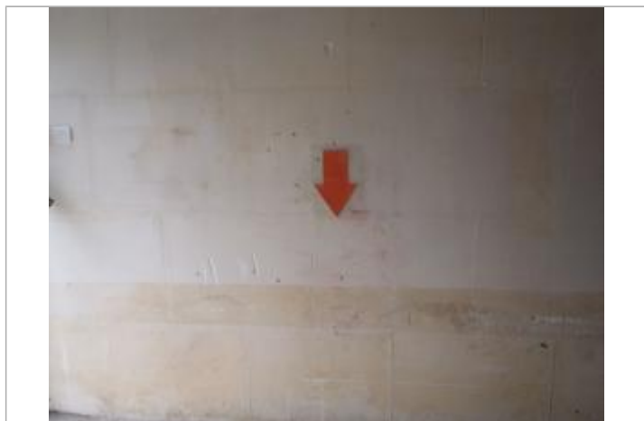
Vue du repère (source : CEREMA, 2018)
