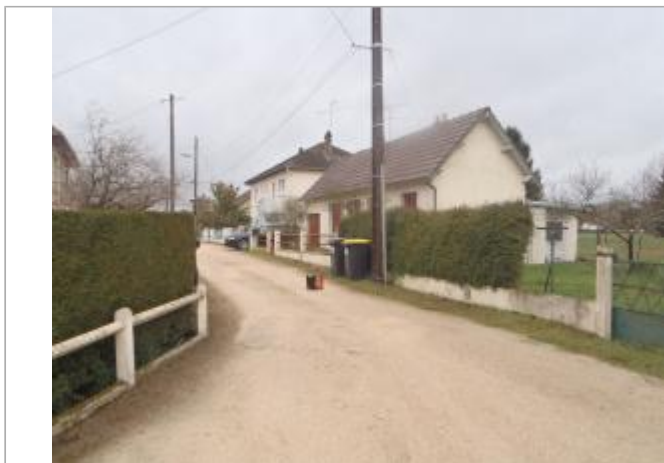
Vue du site (source : CEREMA, 2018)
