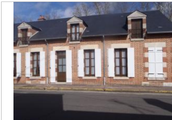
Vue du site (source : CEREMA, 2018)
