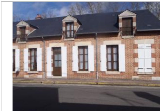
Vue du site (source : CEREMA, 2018)
