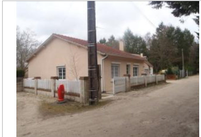
Vue du site (source : CEREMA, 2018)
