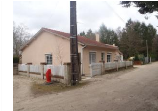
Vue du site (source : CEREMA, 2018)
