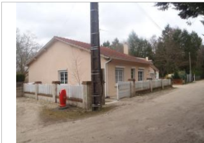
Vue du site (source : CEREMA, 2018)
