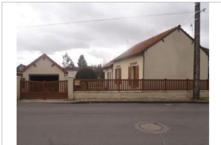
Vue du site (source : CEREMA, 2018)
