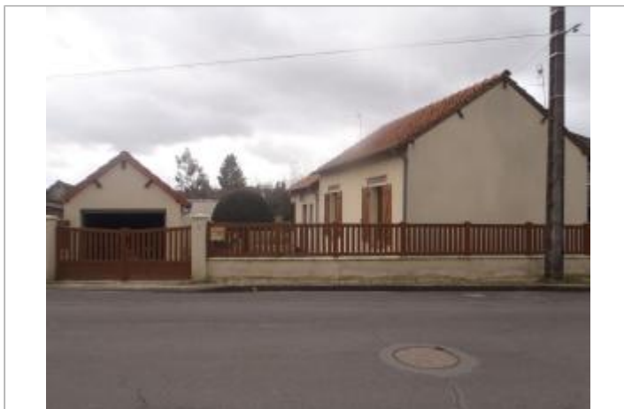
Vue du site (source : CEREMA, 2018)
