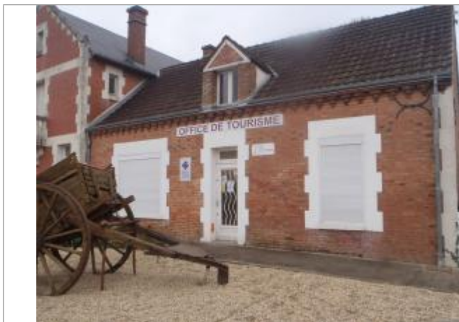
Vue du site (source : CEREMA, 2018)
