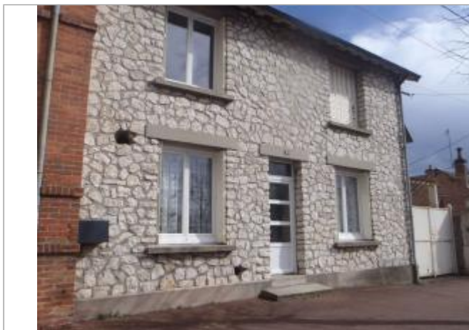
Vue du site (source : CEREMA, 2018)
