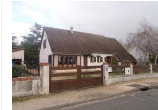
Vue du site (source : CEREMA, 2018)
