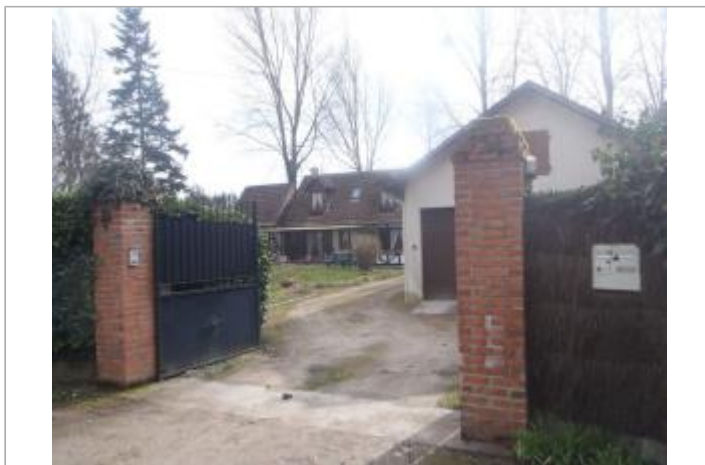
Vue du site (source : CEREMA, 2018)
