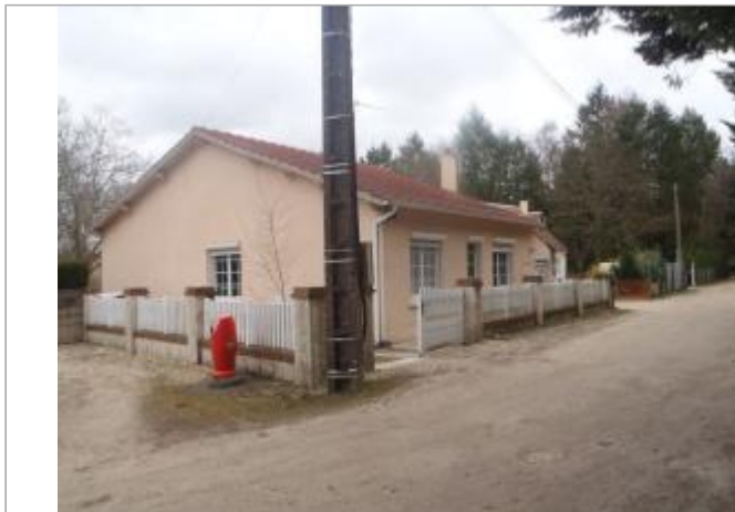
Vue du site (source : CEREMA, 2018)
