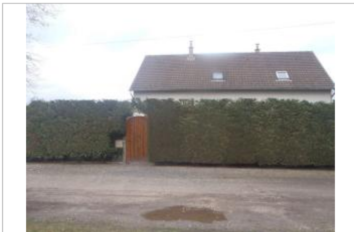
Vue du site (source : CEREMA, 2018)
