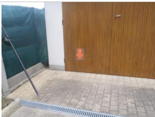
Vue du repère (source : CEREMA, 2018)
