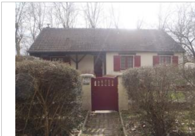
Vue du site (source : CEREMA, 2018)
