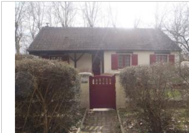
Vue du site (source : CEREMA, 2018)
