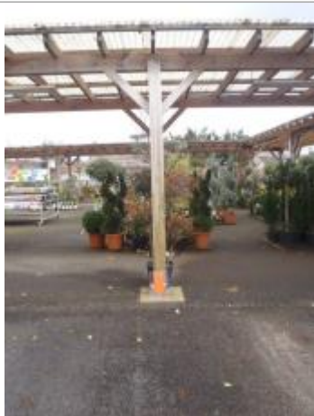
Vue du repère (source : CEREMA, 2018)
