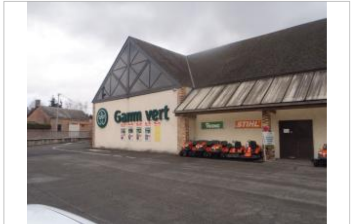
Vue du site (source : CEREMA, 2018)
