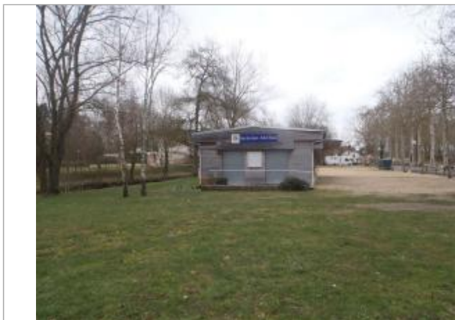
Vue du site (source : CEREMA, 2018)
