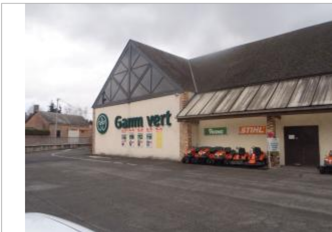
Vue du site (source : CEREMA, 2018)
