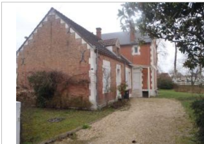
Vue du site (source : CEREMA, 2018)
