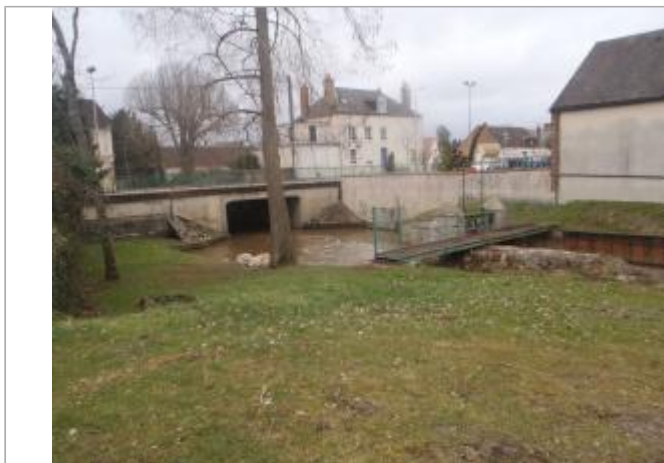
Vue du site (source : CEREMA, 2018)
